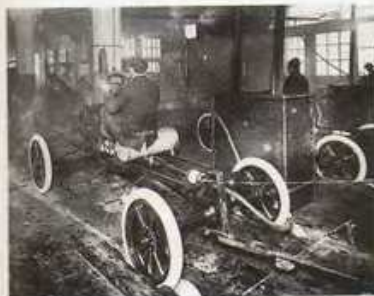
Испытание пускового устройства двигателя автомобиля Модель Т, 1914
