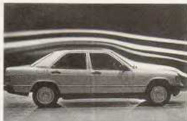
Бруно Сакко, «Мерседес-190» в аэродинамической трубе, 1983
