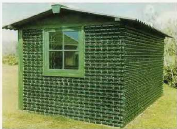
Эскиз образца дома WOB0 (WORLD BOTTLE) по заказу фирмы «A.G. Heineken», нереализованный проект строительства жилья особой формы из ливных бутылок, начало 1960-х
